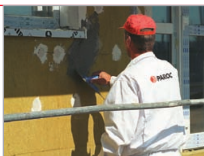
wzmocnienie paskami siatki naroży otworów okiennych i drzwiowych
