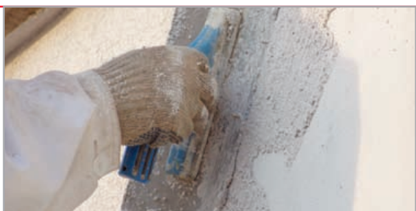
detal - nakładanie tynku
