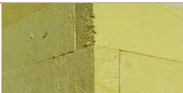
płyty układać mijankowo
