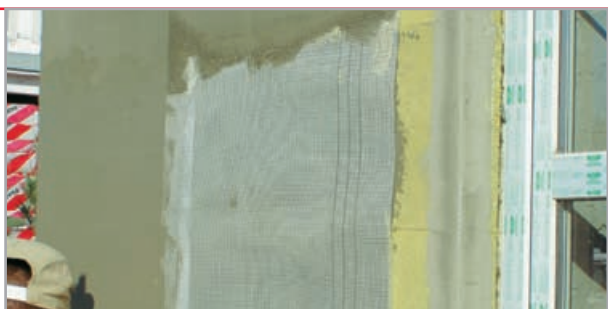
zatopienie siatki z włókna szklanego - zakład co najmniej 10cm
