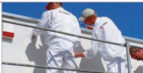
nakładanie i zacieranie tynku cienkowarstwowego
