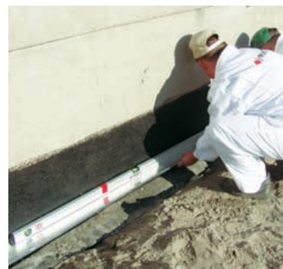
Mocowanie listwy startowej
