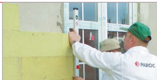
kontrola pionu i poziomu ułożonych płyt
