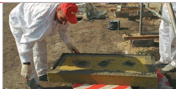
nakładanie zaprawy na płytę - około 40% jej powierzchni
