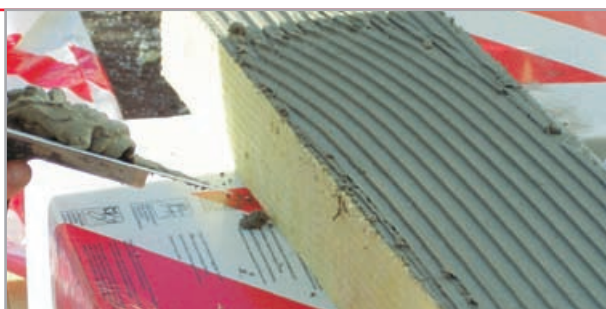
nakładanie zaprawy na płytę - na całej powierzchni - za pomocą paczki zębatej
