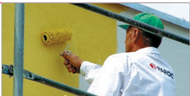
malowanie wyschniętego tynku
