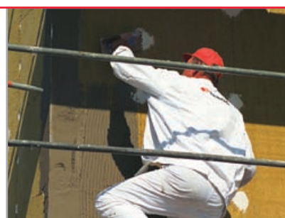
naniesienie zaprawy na płyty
