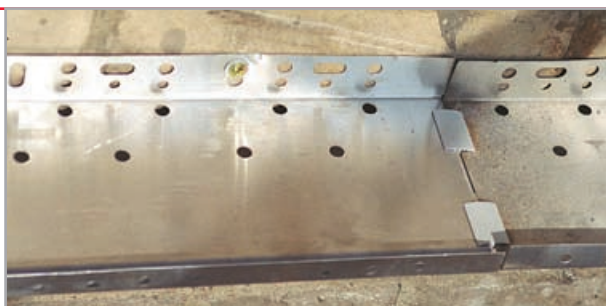
detal - łączenie profili cokołowych
