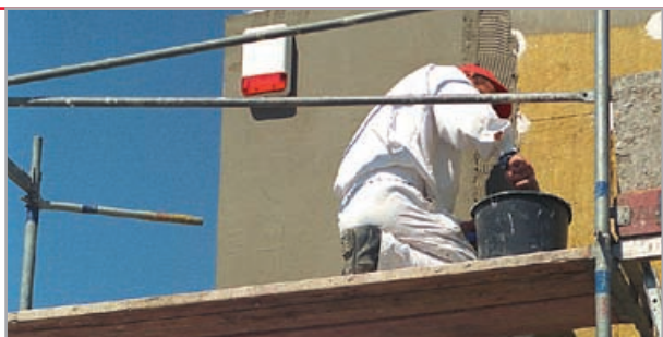
dokładne wyrównanie powierzchni zaprawą
