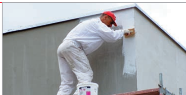
gruntowanie powierzchni - jeśli taki jest zapis w AT
