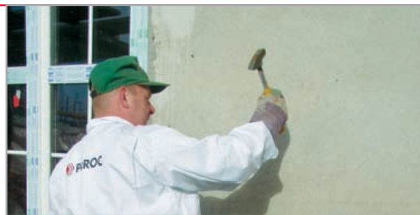
sprawdzenie jakości i nośności podłoża (tynki odparzone należy skuć, a ubytki wyrównać zaprawą)
