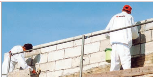
przygotowanie podłoża - usunięcie nierówności i zagruntowanie
