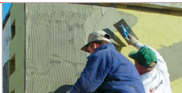
naniesienie zaprawy na płyty z wełny
