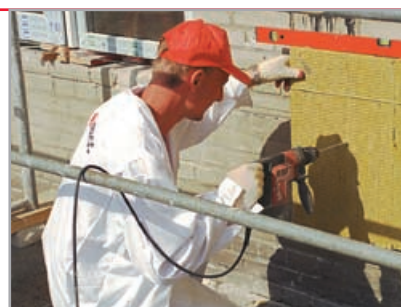
mocowanie płyt do ściany za pomocą łączników mechanicznych
