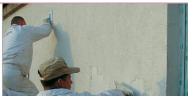
nakładanie i zacieranie tynku cienkowarstwowego
