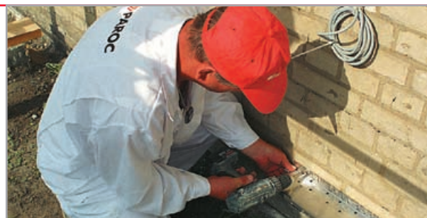
mocowanie profilu cokołowego
