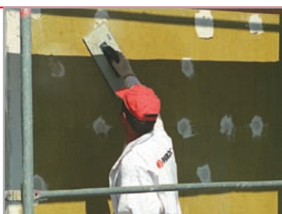
przetarcie płyt tarką w celu zniwelowania nierówności
