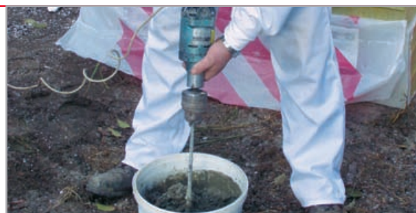
przygotowanie zaprawy klejowej zgodnie z zaleceniami producenta
