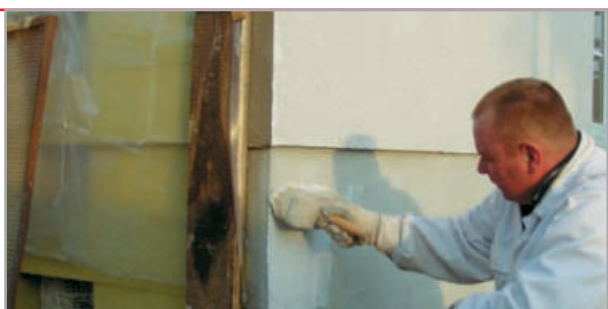
gruntowanie powierzchni - jeżeli jest taki zapis w AT systemu
