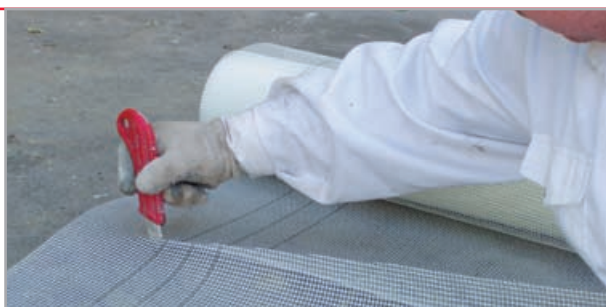
przecięcie siatki zbrojącej
