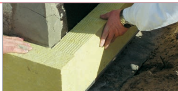
przykładanie płyty do ściany - kolejne płyty przyłożyć kilka centymetrów od poprzedniej, docisnąć i dosunąć do poprzedniej
