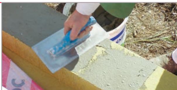
przespachlowanie płyt lamelowych
