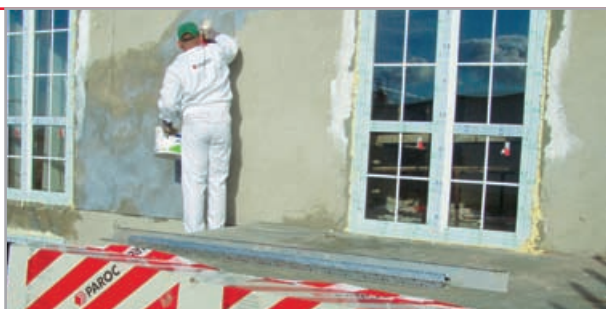
podłoża o dużej nasiąkliwości należy zagrunтовać (patrz AT systemu)
