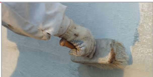
detal - gruntowanie powierzchni
