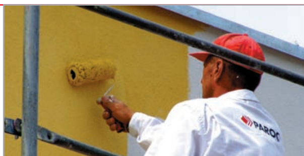
malowanie wyschniętego tynku
