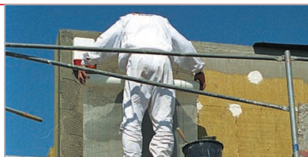
zatopienie siatki zbrojącej - zakład 10 cm
