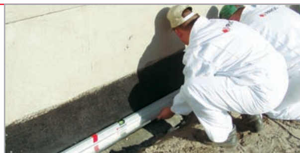
mocowanie profilu cokołowego - poziomo za pomocą kotków rozporowych
