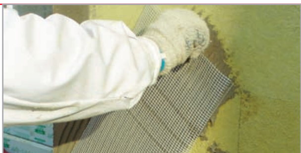
dotatkowe zatopienie wzmacniających pasów siatki we wszystkich narożach otworów drzwiowych i okiennych
