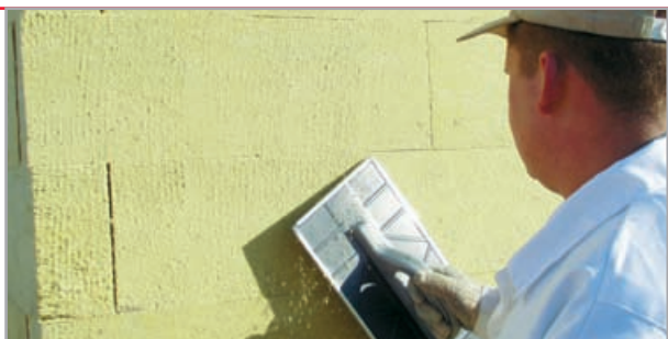
przetarcie płyt tarką, zmiecenie pyłu mokrą szczotką - odpalenie
